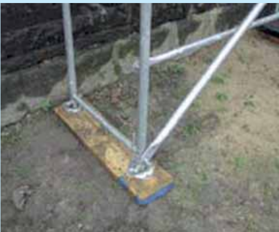
Fot. 1. Posadowienie prawidłowe
