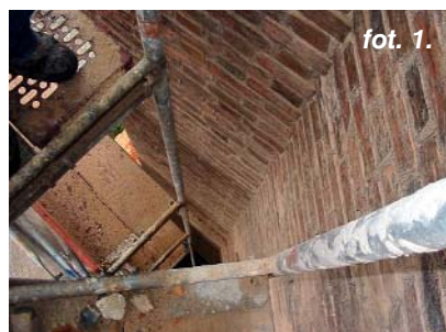
Rys. 8. Elementy pomostu roboczego wykonane z odpowiednio usztywnionych profili
